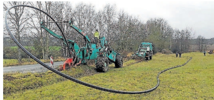
VÝSTAVBA VODOVODU nedaleko Benešovic. Foto: Tomáš Petráň
