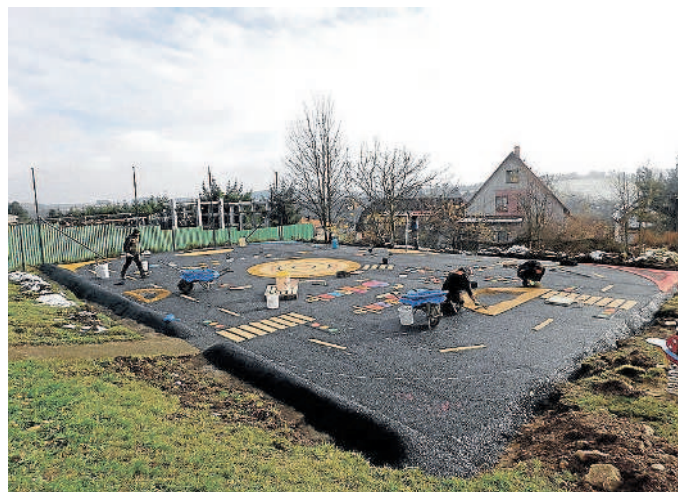
STAVBA víceúčelového hřiště v Mateřské škole Pošumavská v Tachově. Foto: Ladislava Pitrová
